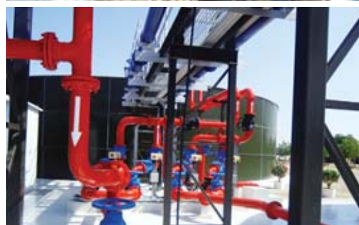
Sharjah Municipality Capitox STP, Sharjah, UAE
