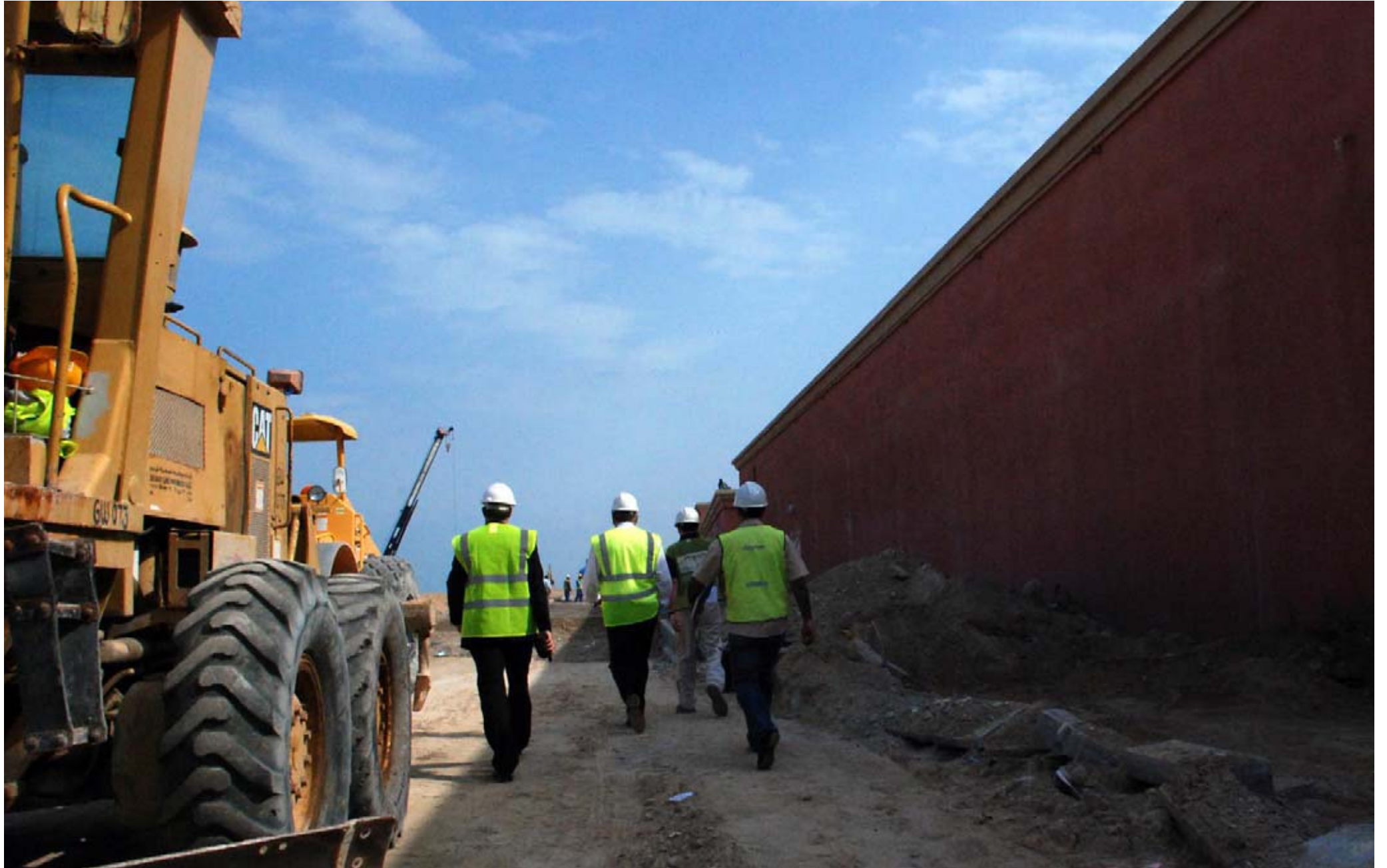
迪拜棕榈人工岛群(The Palm)亚特兰蒂斯(Atlantis)建筑工地
