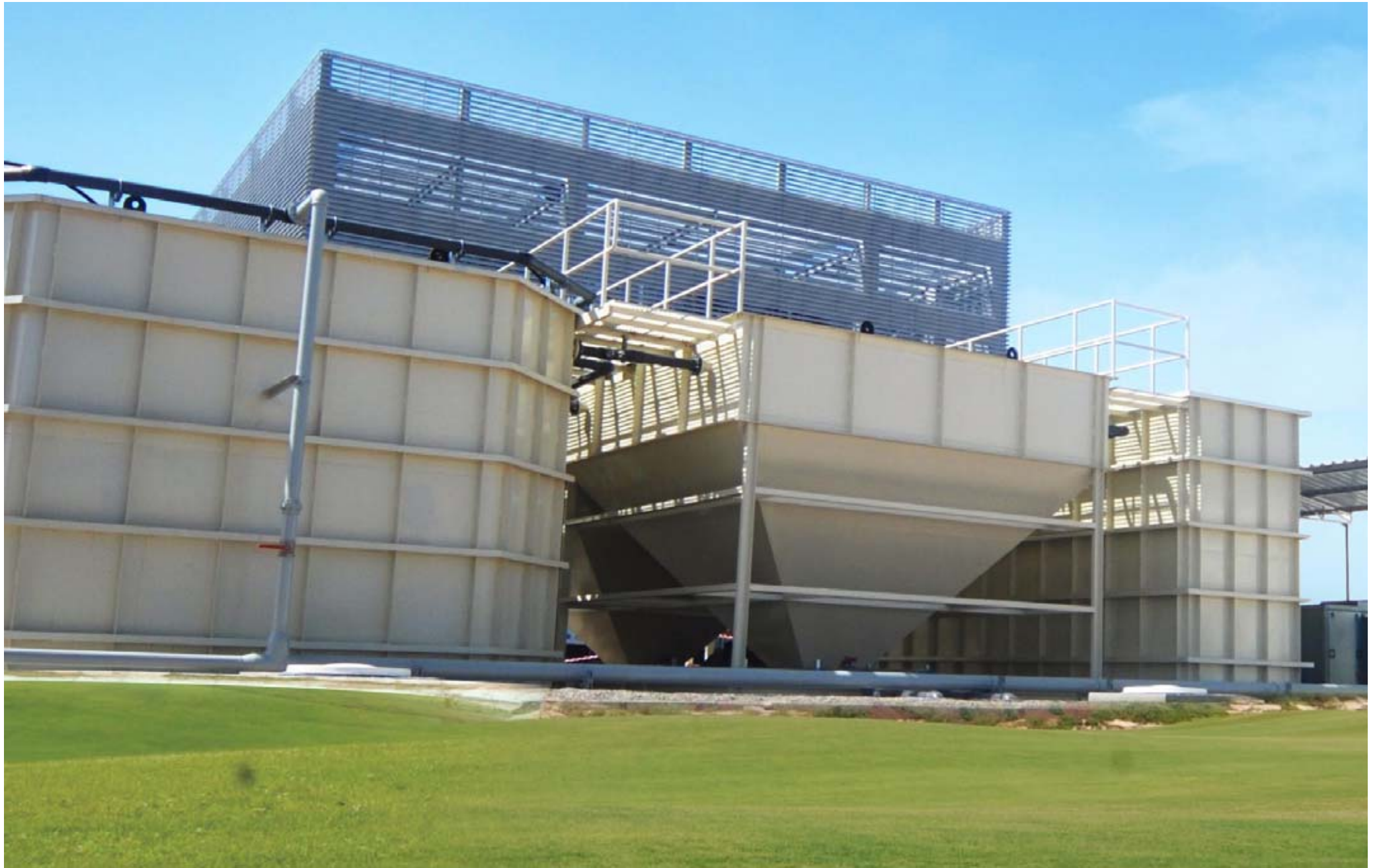
阿布扎比阿力弗(Al Reef)别墅的移动床生物反应器(MBBR)
