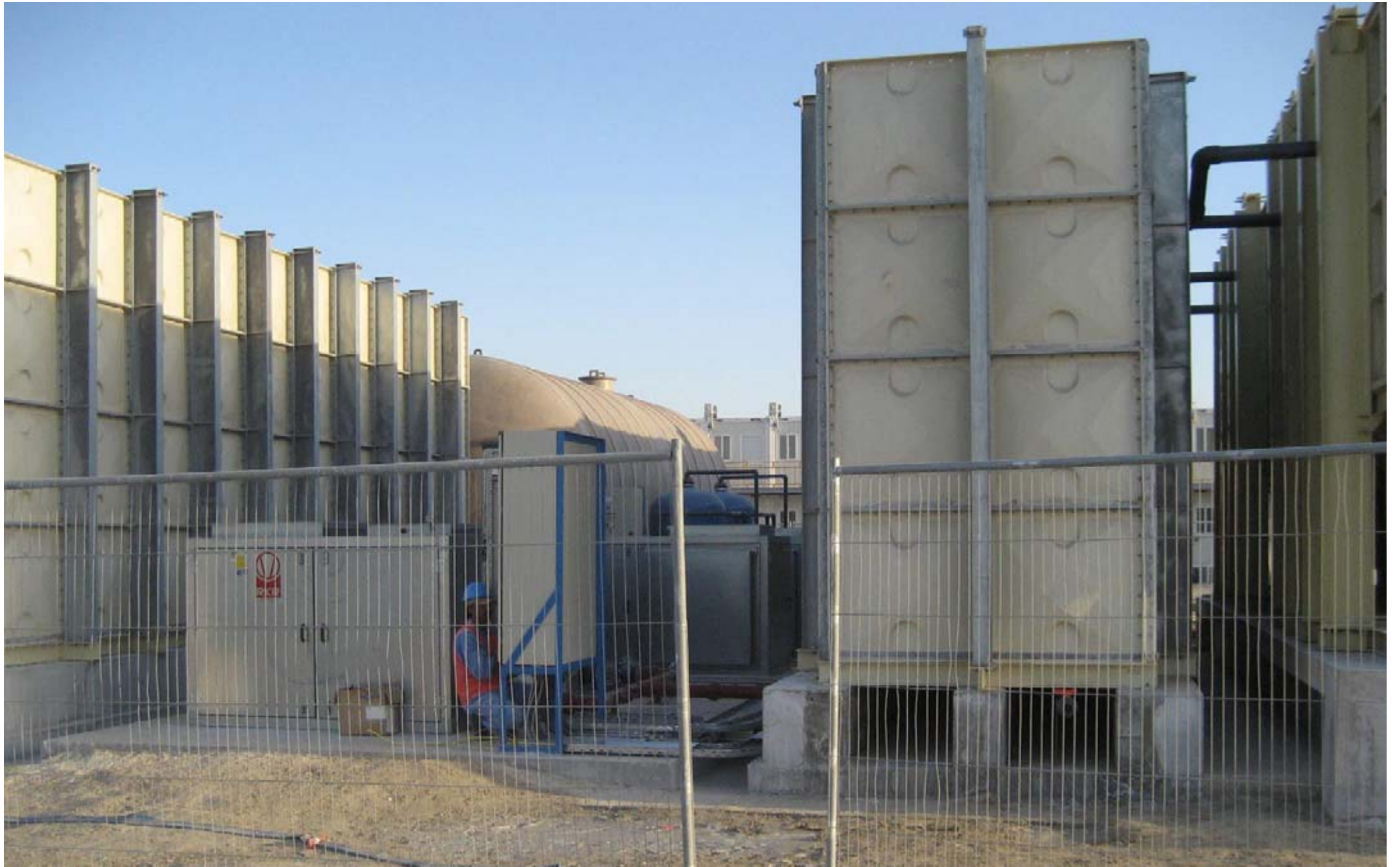
阿布扎比亚斯岛工人营地污水处理厂 (STP)
