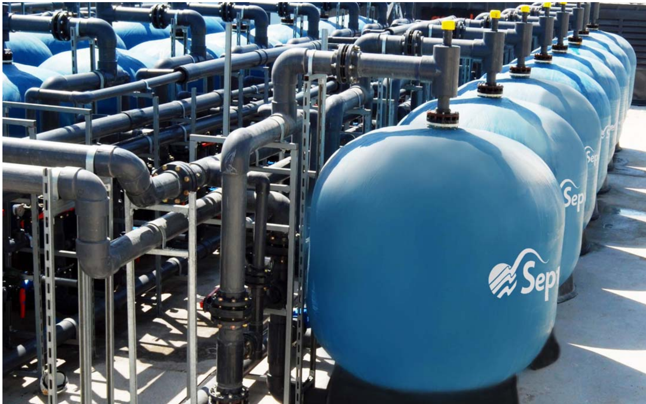
萨迪亚特(Saadiyat)岛海水淡化装置多媒介过滤器
