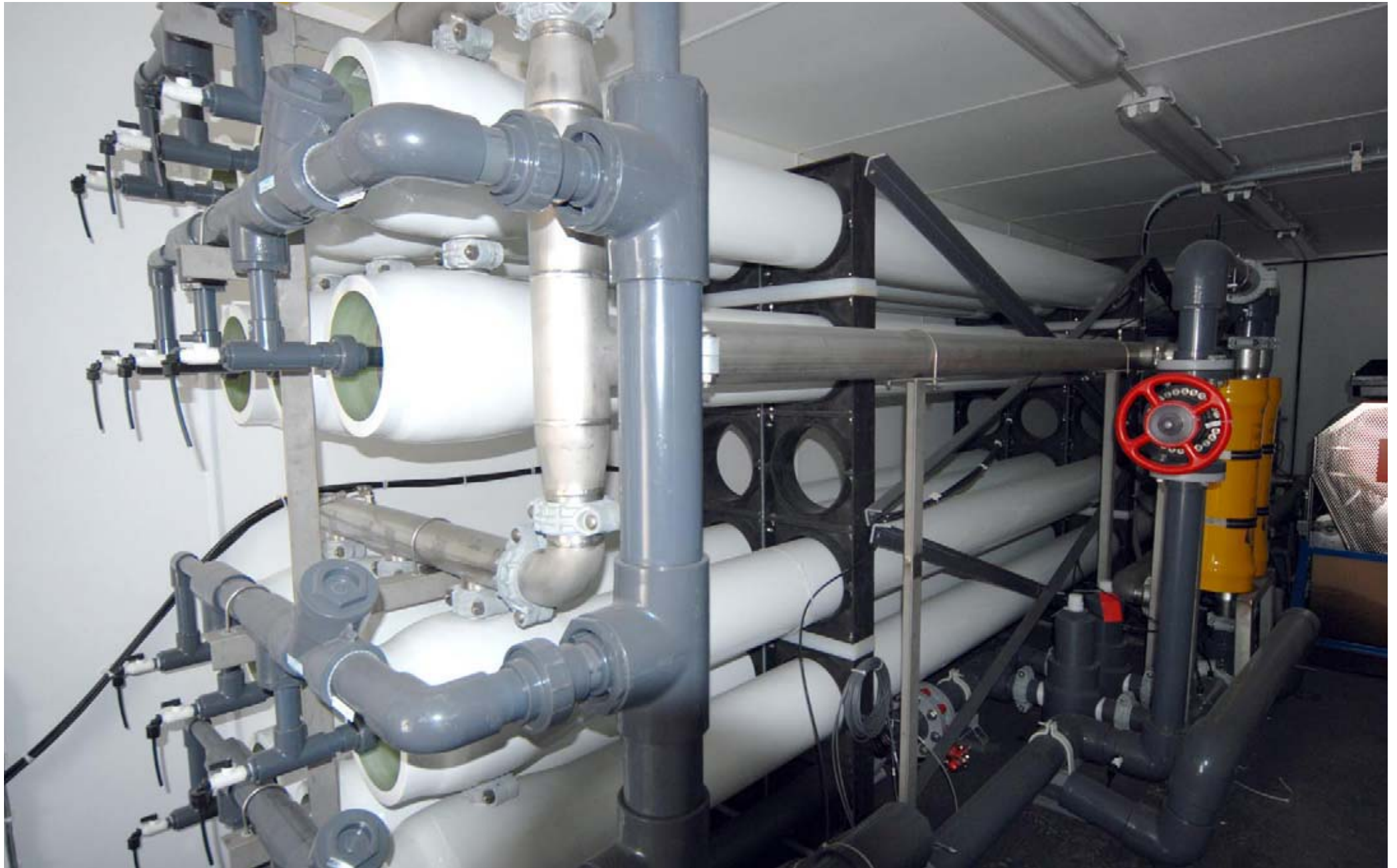
海水反向渗透(SWRO)膜罐及能量回收公司(ERI)系统
